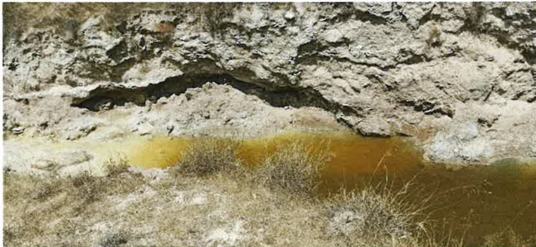
תמונה 3 – תעלת כניסת נגר לאגם הצפוני. ניתן לראות בתמונה את קריסת דופן התעלה ואת שכבות המילוי.
