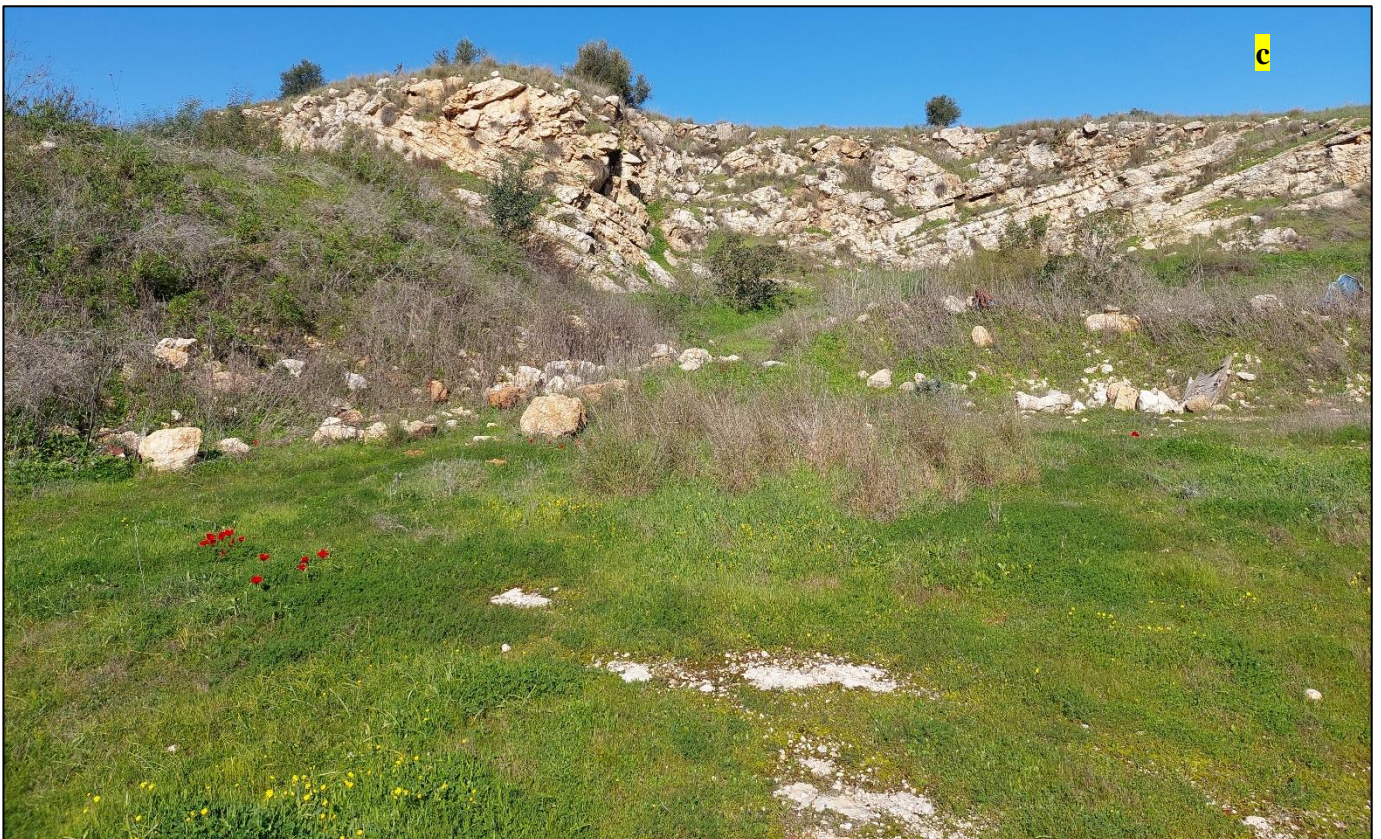
תמונה 6- מילוי לא מבוקר ומדרונות חצובים בפאה הצפונית (צולם לכיוון צפון)
